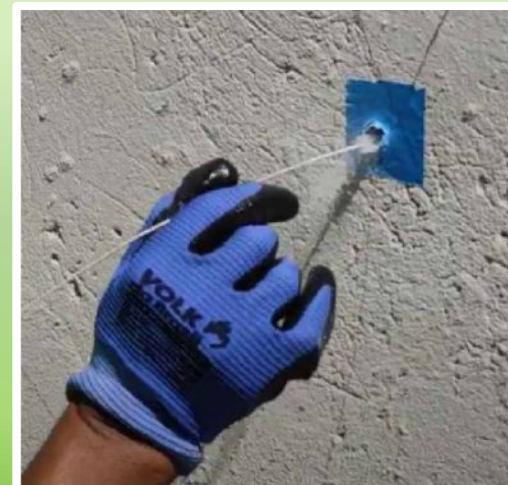
Figura 12: Limpeza do furo com escova de cerdas duras
