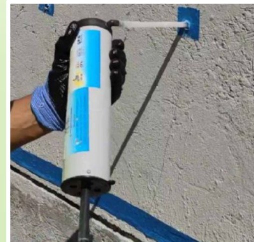
Figura 11: Limpeza do furo com bomba de ar manual
