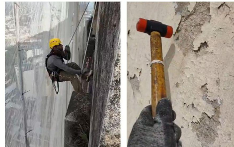
Figura 1 e 2 – Execução do teste de percussão
