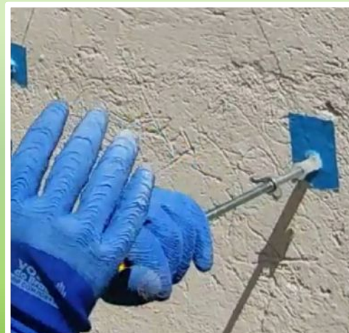
Figura 13: Introdução da camisa com auxílio de gabari
