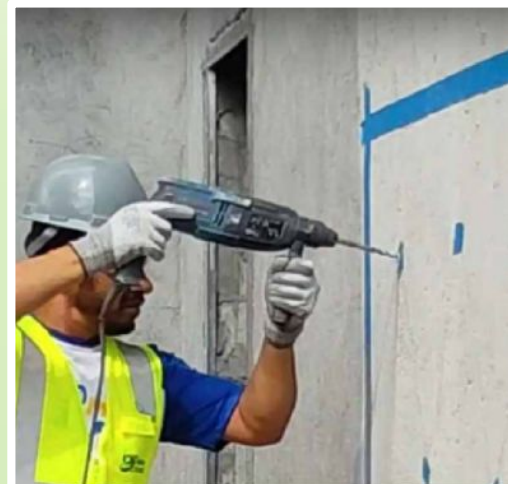
Figura 10: Realização do furo com diâmetro de 10mm
