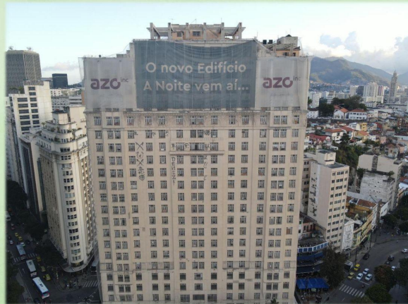
Procedimento executivo de recuperação de fachada – R01
