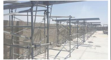
Figura 2 - Ilustração Perfl I sobre andaime fixado na laje
