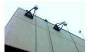
Figura 4 - Ilustração suporte metálico sobre platibanda estrutural
