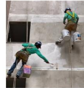
Figura 28 - Aplicação do selador acrílico na fachada
