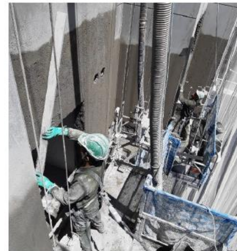
Figura 16: Sarrafeamento da argamassa.
