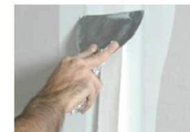
Figura 48 - Aplicação da fita
