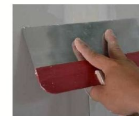
Figura 49 - Aplicação final do rejunte sobre a fita
