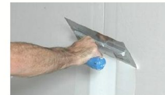
Figura 47 - Aplicação da 1ª camada de rejunte
