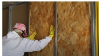
Figura 44 – Colocação da lã entre os montantes
