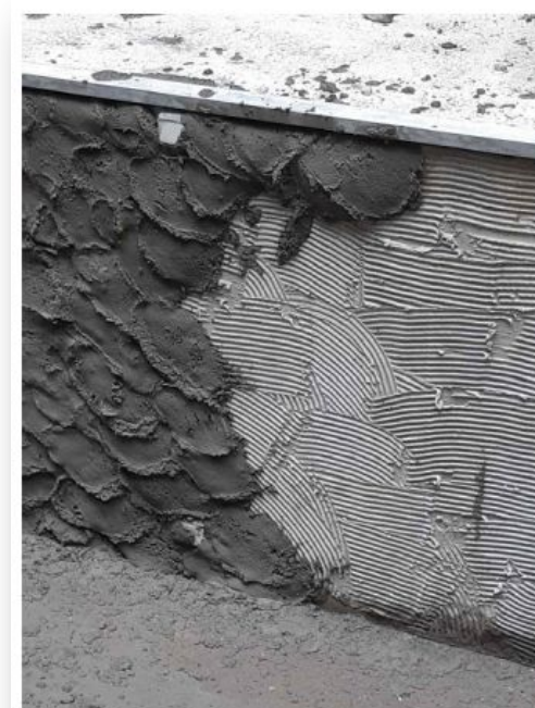
FOTO 2: EXECUÇÃO DA CAMADA DE REGULARIZAÇÃO DE ARGAMASSA
