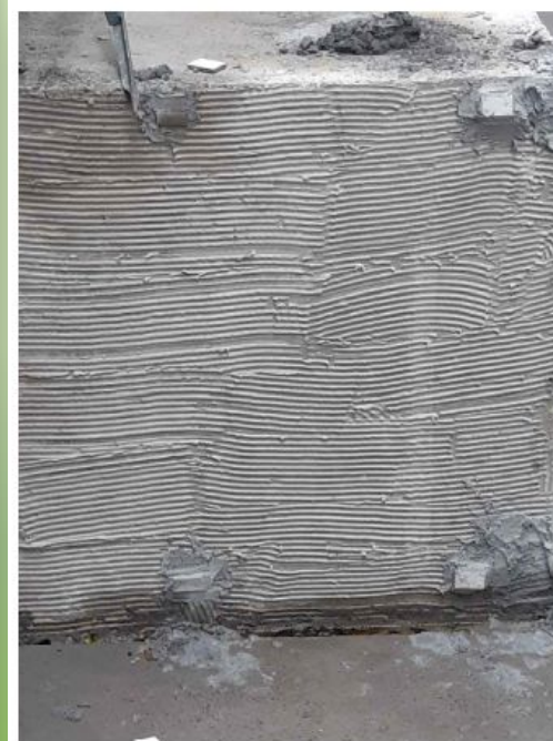
FOTO 1: CHAPISCO EXECUTADO COM DESEMPENADEIRA E TALISCAS
