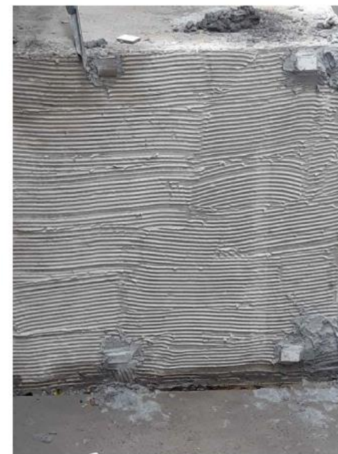
FOTO 1: CHAPISCO EXECUTADO COM DESEMPENADEIRA E TALISCAS
