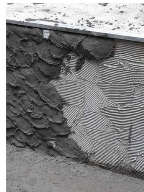
FOTO 2: EXECUÇÃO DA CAMADA DE REGULARIZAÇÃO DE ARGAMASSA
