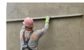
Figura 15 - Sarrafeamento da argamassa.
