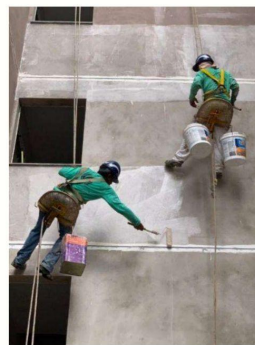
FIGURA 40 – APLICAÇÃO DO SELADOR ACRÍLICO NA FACHADA
