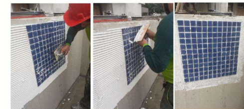
FIGURAS 41, 42 E 43 - FIXAÇÃO DO REVESTIMENTO, PREENCHIMENTO DAS JUNTAS, ASSENTAMENTO FINALIZADO
