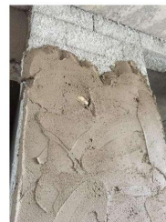
Figura 13 – Primeira chela de argamassa
