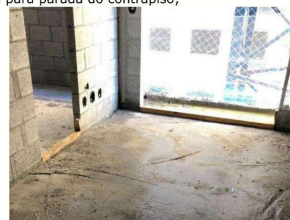
Figura 9 - Paradas de contrapiso com fôrmas de madeira
