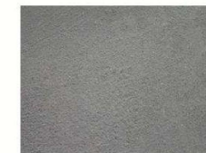
Figura 24 - Acabamento reforçado alisado
