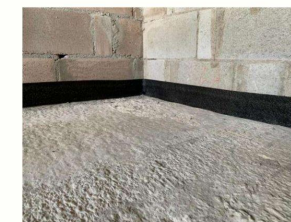
Figura 2 – Rodapé de polietileno expandido autocolante (Fitapiso) fixado na base da alvenaria como junta de dessolidarização do contrapiso com argamassa colante
