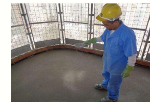
Figura 12 - Polvilhamento de cimento
