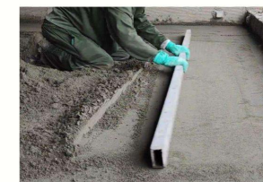
Figura 11 - Sarrafeamento com régua de alumínio
