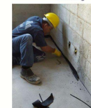
Figura 23 – Corte do excedente da manta
