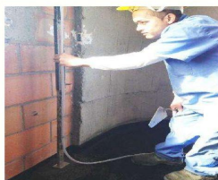
Figura 8 - Execução de talisca com nível alemão
