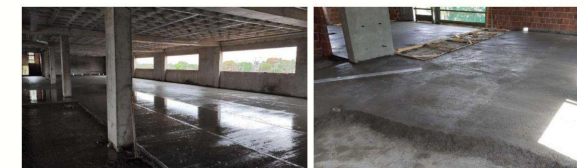
Figuras 24 e 25 – Contrapiso semi-plástico no estado endurecido
