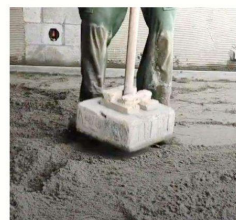
Figura 10 - Compactação de massa com soquete padrão
