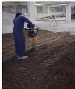
Figura 1: Compactação mecânica do subleito
