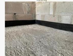
Figura 2 – Rodapé de polietileno expandido autocolante (FitaPiso) fixado na base da alvenaria como junta de dessolidarização do contrapiso com argamassa colante
