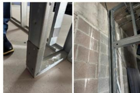
Figura 18 e 19 – Fixação do montante na guia inferior e reforço com montante duplo e madeira tratada
