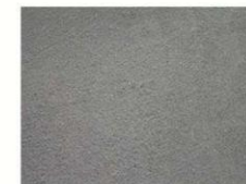
Figura 24 - Acabamento reforçado alisado
