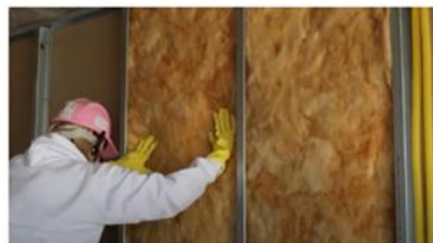
Figura 44 - Colocação da lã entre os montantes
