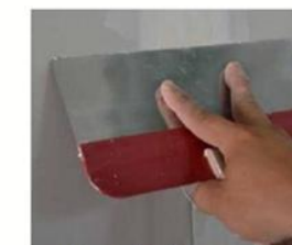
Figura 49 - Aplicação final do rejunte sobre a fita
