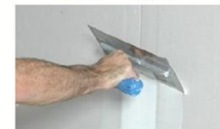
Figura 47 - Aplicação da 1ª camada de rejunte
