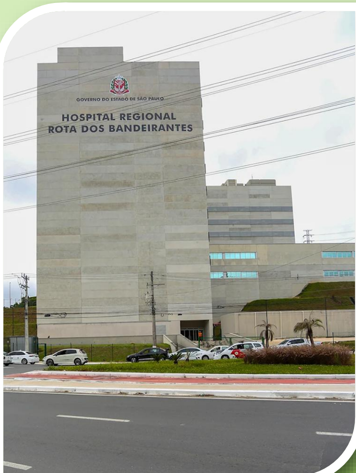
HOSPITAL REGIONAL ROTA DOS BANDEIRANTES
