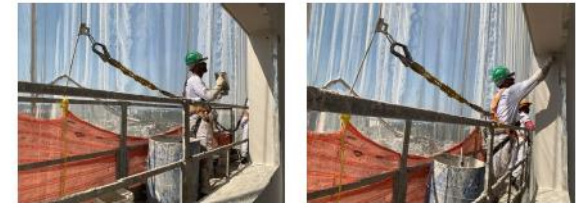
Figura 29 e 30 - Execução de textura desempenada na fachada
