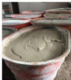
Figura 1 e 2: Argamassa estabilizada armazenada na obra.
